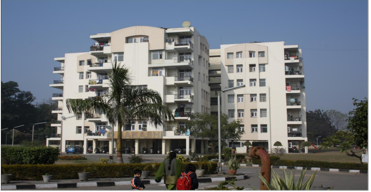
चित्र 4: खुली निचली मंजिल के साथ सामान्य आरसी ढांचे वाली इमारत
