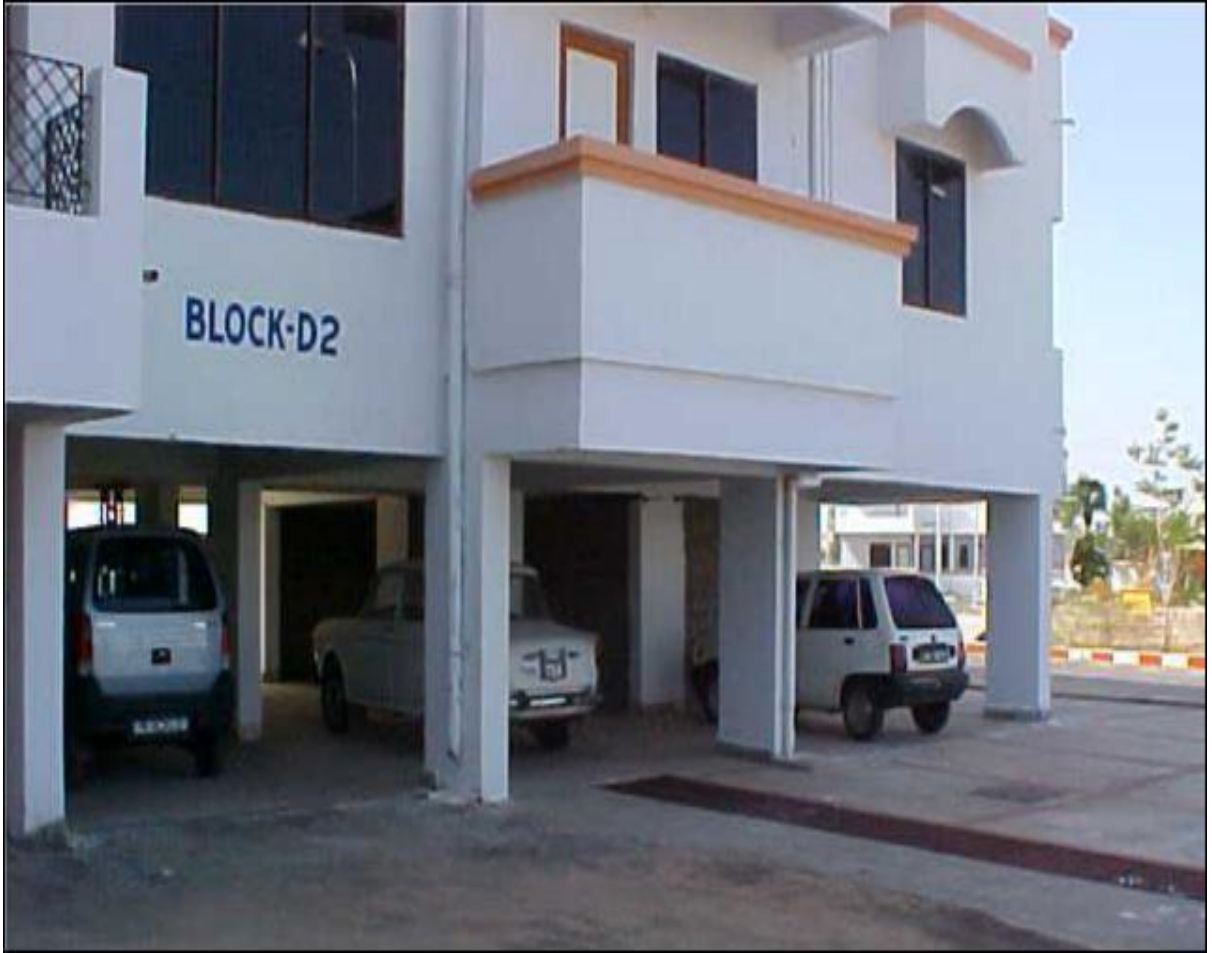
चित्र 5: खुली निचली मंजिल में 230mm चौड़े खम्भे के साथ आरसी ढाँचे वाली इमारत
